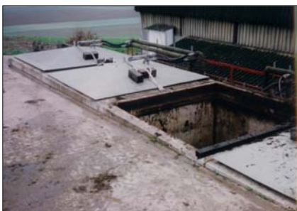
Installation de M. Chabloz à Lully (CH)
