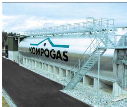
Installation de Oetwill (CH) modèle Kompostogas
