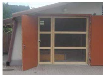
Werden bei Hitze die Stalltore geöffnet (z. B. in Kombination mit Grossraumlü- ftern), soll ein Drahtgitterrahmen in der Toröffnung verhindern, dass Haus- und Wildtiere in den Stall gelangen.
