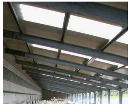
Lichtplatten im Dach des Aussenklimabereiches sollten in Hitzeperioden bei starker Sonnenexposition beschattet werden.
