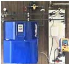
vor Ort aus handelsüblichem Kochsalz eine Desinfektionslösung für das Tränkwasser her. Dieses Verfahren bietet einen wirksamen Schutz gegen die Verkeimung der Tränkanlagen; der Biofilm in den Leitungen wird kontinuierlich abgebaut. Mit der erzeugten Desinfektionslösung kann auch der Maststall gereinigt werden.
