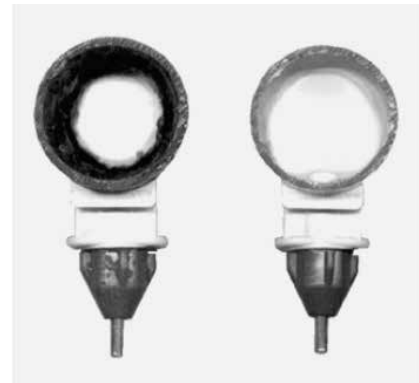
Tränkeleitung mit Biofilm (links) sowie gereinigte Leitung (rechts)
