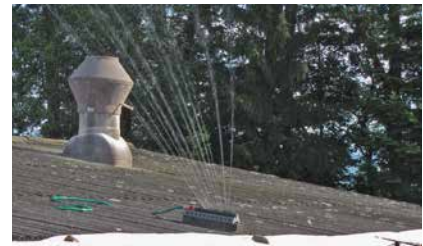
In Hitzeperioden können Vorplätze und Dächer zur Kühlung berieselt werden; ein ausgelegtes Vlies (weiss) speichert das Wasser.
