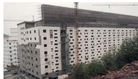
Solche bis zu 13-stöckigen «Schweine-Hochhäuser» werden gegenwärtig in China errichtet. Foto: Twitter/Bill Northey
