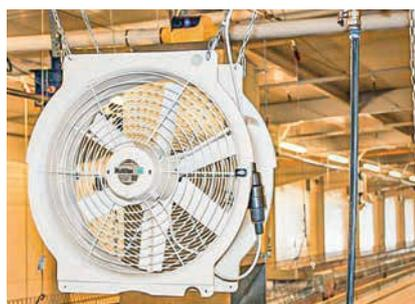
Brassage de l'air à l'aide d'un ventilateur horizontal et répartition horizontale de l'air.
