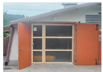
*Si les portes du poulailler sont ouvertes lorsqu'il fait chaud (p. ex. en combinaison avec des ventilateurs de grande capacité), un grillage doit être installé dans l'ouverture de la porte afin d'empêcher les animaux domestiques et sauvages de pénétrer dans le poulailler.*
