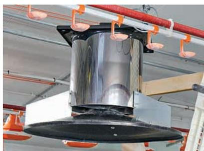
Brassage de l'air à l'aide d'un ventilateur vertical et répartition horizontale de l'air.
