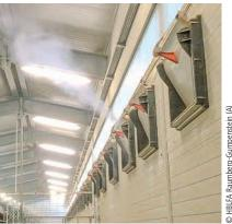
Une répartition régulière de l'air frais est importante pour un climat équilibré dans le poulailler. Des cartouches fumigènes peuvent être utilisées afin de visualiser les flux d'air dans le poulailler.
