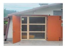
Si les portes du poulailler sont ouvertes lorsqu'il fait chaud (p. ex. en combinaison avec des ventilateurs de grande capacité), un grillage doit être installé dans l'ouverture de la porte afin d'empêcher les animaux domestiques et sauvages de pénétrer dans le poulailler.
