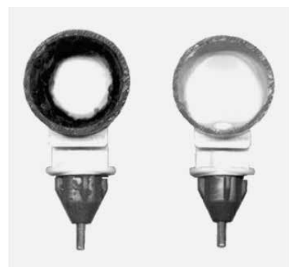
Conduite d'abreuvement avec biofilm (à gauche) et conduite nettoyée (à droite).
