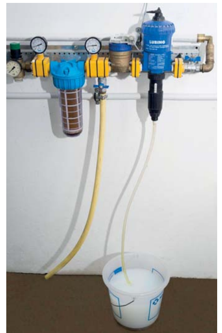
Illustration 3: Administration de la solution vaccinale avec un Dosatron
