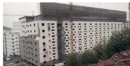
La Chine construit actuellement ce type de fermes porcines, pouvant aller jusqu'à 13 étages. Photo: Twitter/Bill Northey
