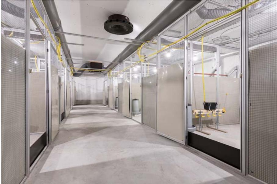
*Kleiner Versuchsstall, eingerichtet mit acht Versuchsabteilungen für je 30 Legehennen. Jedes Abteil kann separat kontrolliert belüftet werden.*
